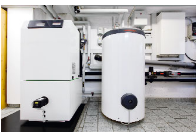
La nouvelle installation
