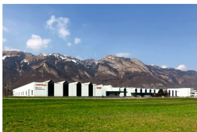
Production des chaudières à Sennwald (Suisse)
