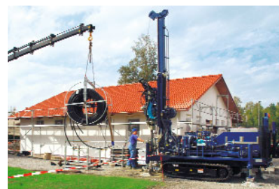
Forage géothermique par Géoforage
